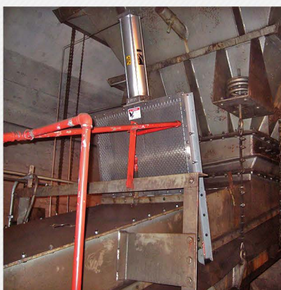
Задвижки 610 мм x 965 мм установлена в системе вибропитателя для дозирования потока угля
