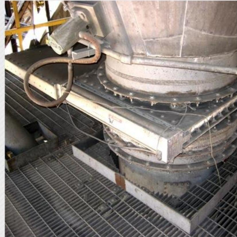
Задвижка 26" (660мм) с двумя цилиндрами
