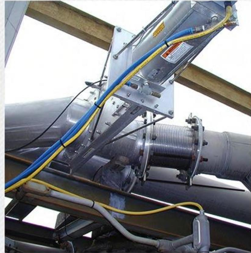
Задвижка 12" (305мм) работает с порошковой полиэтиленовой смолой
