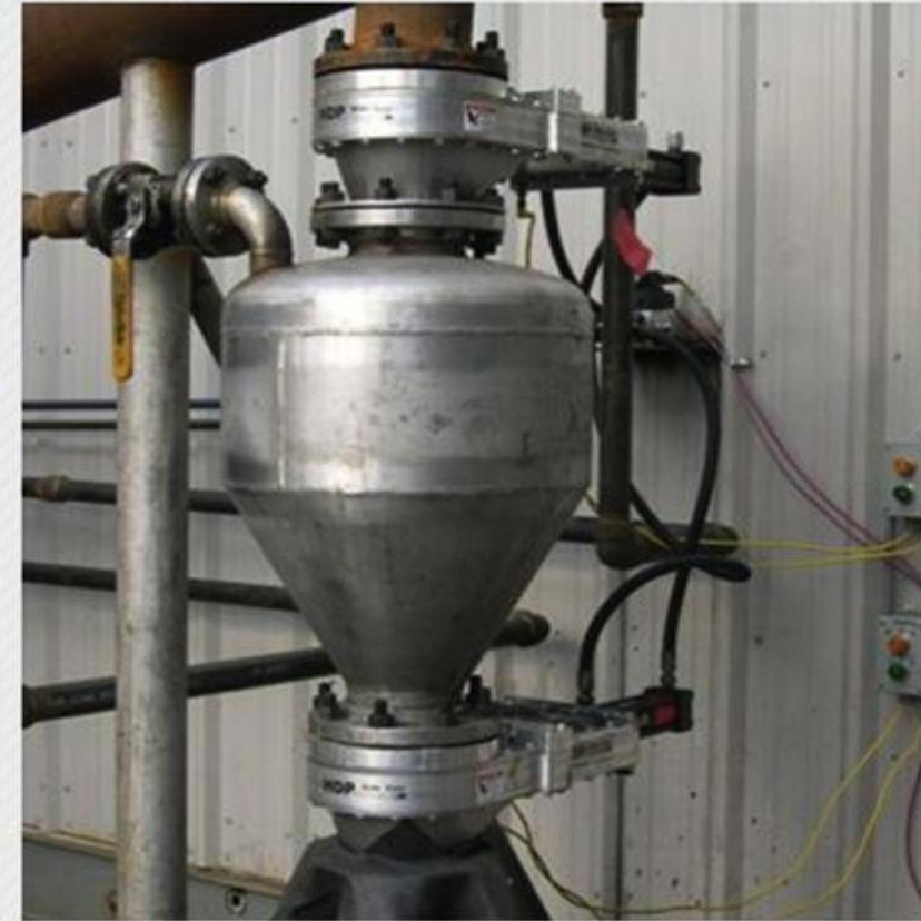
Задвижка 12" (305мм) над и под магнетательным баком работает с углем и древесной щепой
